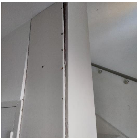
Figuur 6 Kieren rondom koof hal naast meterkast
