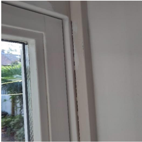
Figuur 1 Kieren rondom draaikiepraam achtergevel
