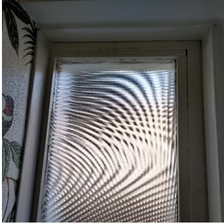
Figuur 4 Kieren rondom raam voorzijde
