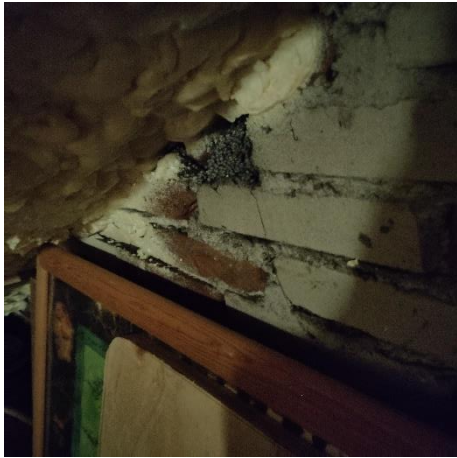
Figuur 10 Warmtelekken bij locaties zichtbare EPS parels
